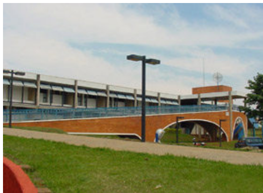
Figura 1 – Fachada do Bloco onde funciona a Rádio e Tv Universitárias, a Dirco e a Gráfica da UFU.
